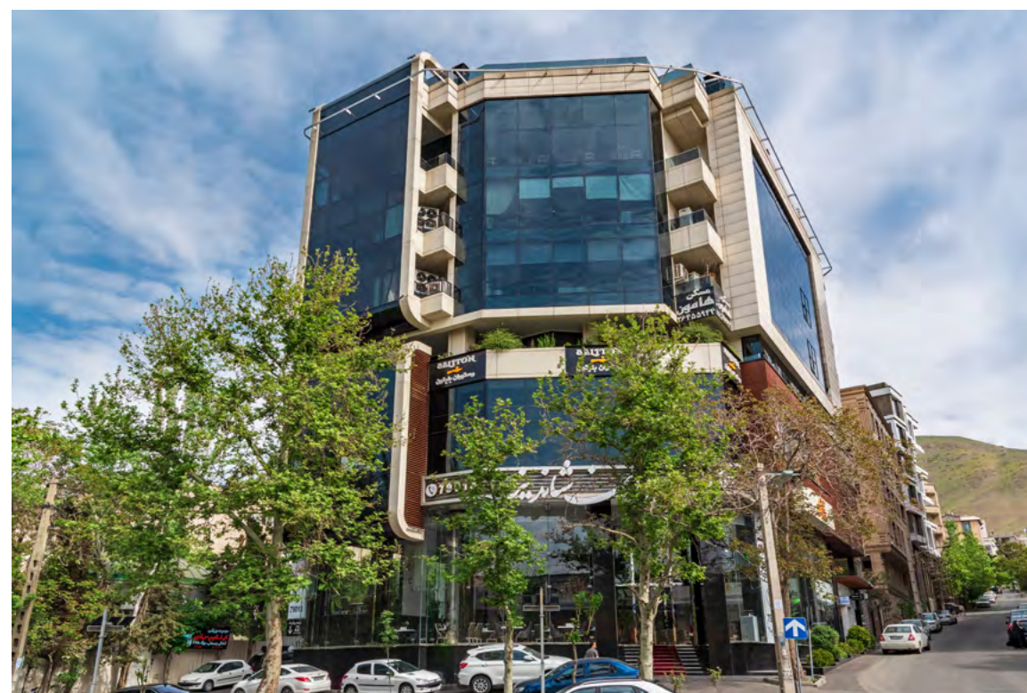
■ ساختمان اداری لیدو - کاشانک
