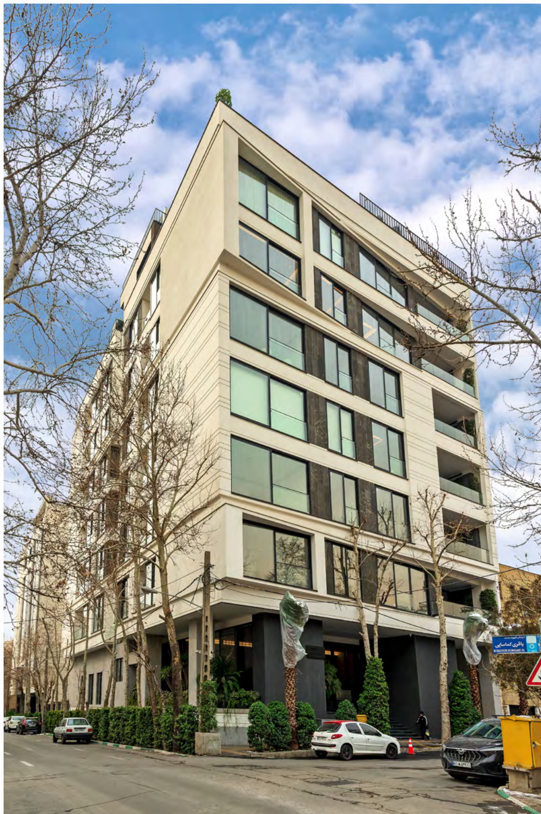
■ ساختمان هومر آقای حاجتی - دروس
